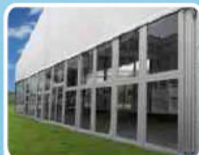
玻璃墙 glass wall
