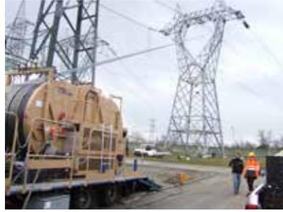
Cabrestante y frenadora doble con tambores de Ø 2 m con sectores de acero intercambiables y circuitos hidráulicos redundantes
