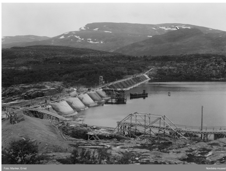
Figur 2 Suorvadammen under uppbyggnad
