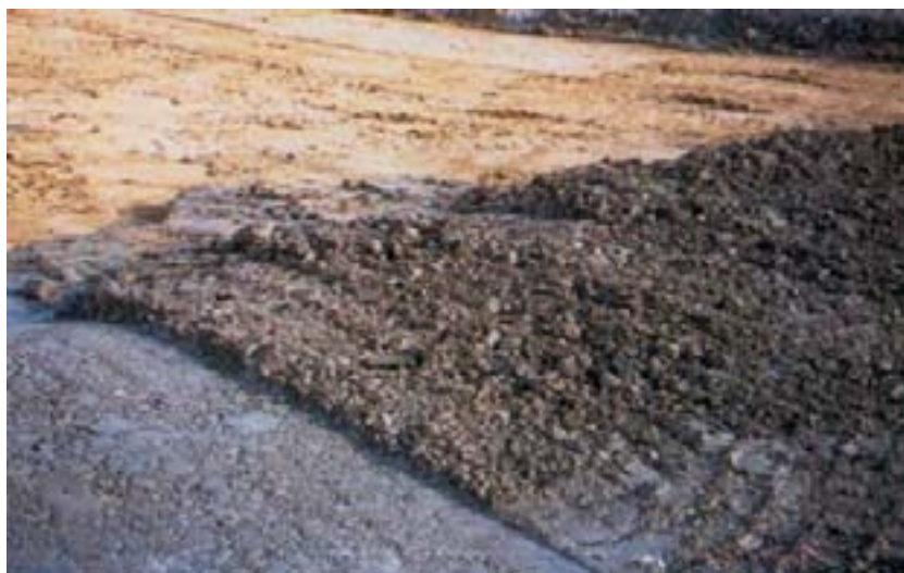
Figur 9 Lermaterialet ("Clay noodles") i första lagret före kompaktering
