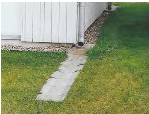
Exempel på lokalt omhändertagande av dagvatten, LOD, på privat mark.
