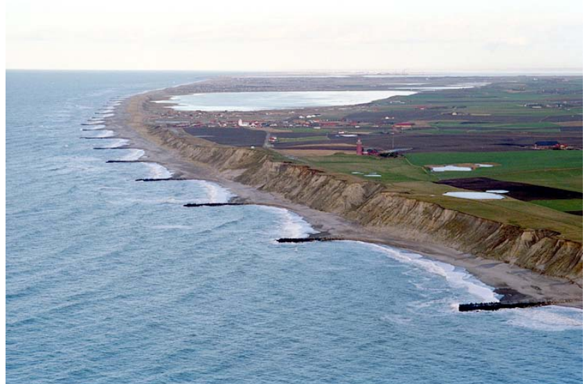
Figur 7.10 Hövder för stabilisering av en kuststräcka. (Foto: Kystdirektoratet, Danmark)
