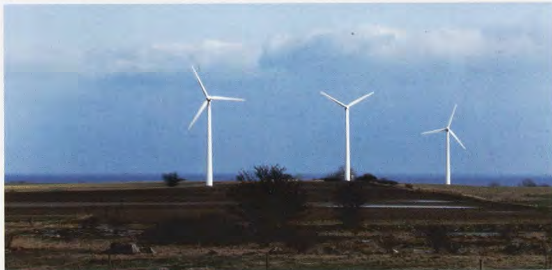
Tre vindkraftverk i rad. Turbinhusen ligger inte i helt i rät vertikallinje p.g.a. topografin.
