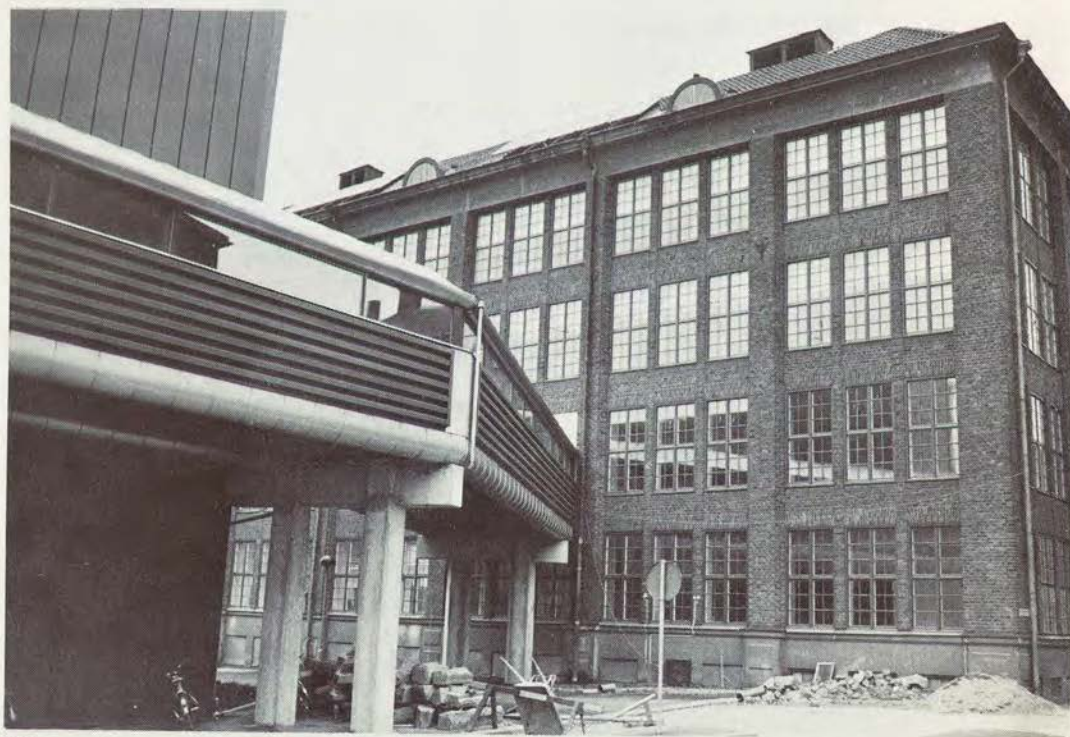
Figur 4. En förbindelsegång mellan Rinmansskolan och C E Johanssons har fått byggas över Västeråsvägen.
