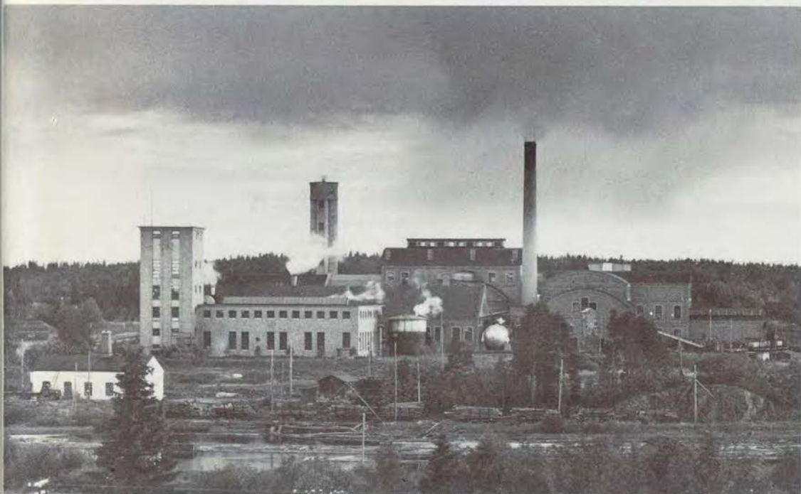
Figur 3. Sulfitfabriken i Robertsfors strax före nedläggningen 1948.
