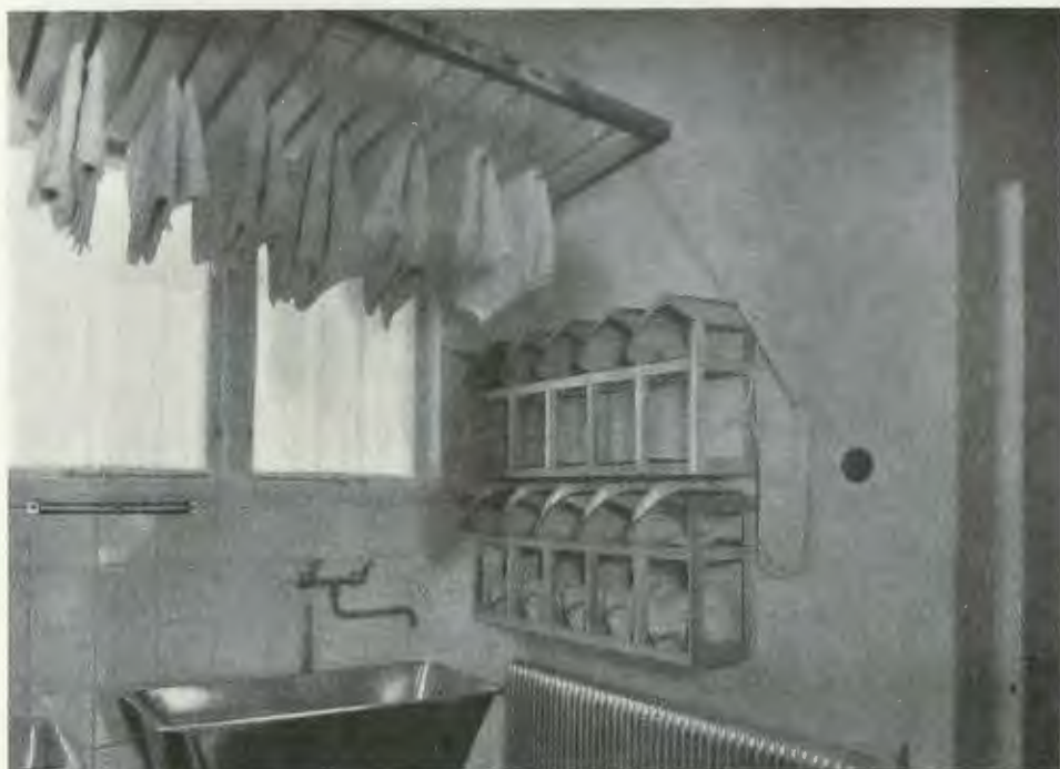
Fig. 61. Bild av skötrum i daghem i Kristianstad. Lägg märke till den hissbara torkställningen, barnbadkaret av rostfritt stål samt den öppna hyllan för pottor och tvättskålar.
