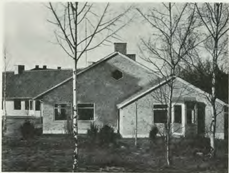
Fig. 54—55. Ett par bilder från Vallbacksgården i Gävle. Barnstugan blev färdig 1947 och är uppförd i en öppen vinkel. Den låga, trivsamma byggnaden, väl anpassad efter barnens egen skala och miljö, innehåller daghem för 27 barn, förskolor för 110 barn samt eftermiddagshem för 15 skolbarn.
