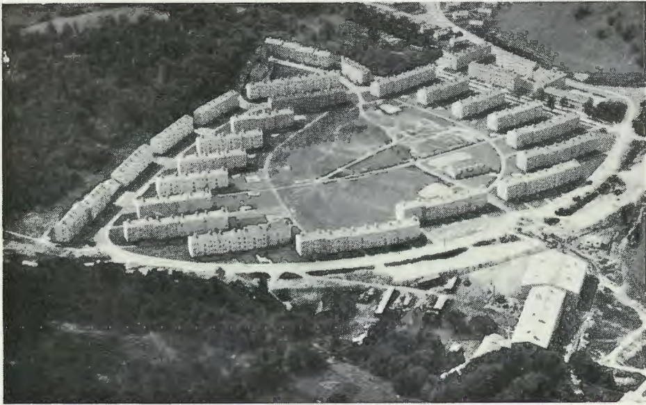
Fig. 10. Barnet i centrum: bilden från det nya bostadsområdet Torpa i Göteborg. Innanför ringen av bostadshus synes en låg byggnad — det är barnstugan. På vinden ha samlings-salar inretts avsedda för fritidsverksamhet inom området. I bildens högra kant se vi den nya skolan. Småskolan — som försvinner in i grönskan — är en vacker envåningsbyggnad i trä, vilken på ett stimulerande sätt anslutits till den stora skolans tegelbyggnad: varje klassrum har direkt utgång till sin egen lekplats och hela småskolebyggnaden har i övrigt utformats så att barnen skola känna trivsel och, ro.
