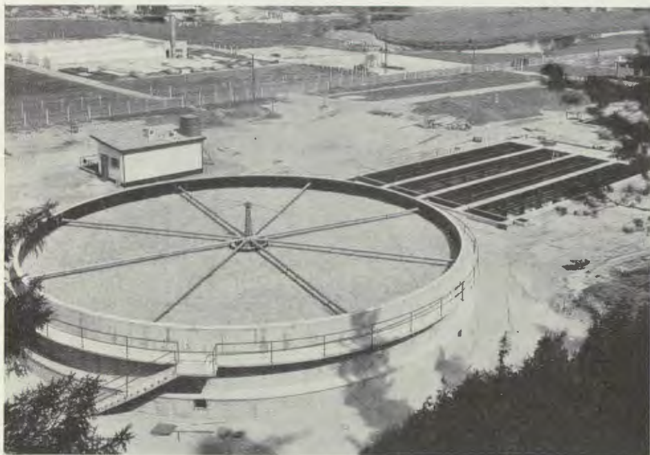
Fig. 51. Biologisk droppbädd, högbelastad. T. h. sedimenteringsbassänger med kedjeskrapor. Bakom droppbädden pumpstation för återföring av renat vatten. Borås.
