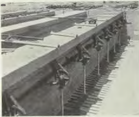
c. Inblåsning av finfördelad luft genom porösa rör utmed bassängens ena långsida, för inspektion monterade på svängbara armar. Chicago Pump Co.
