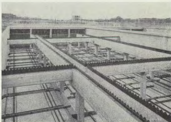
Fig. 42. Sedimenteringsbassäng med rektangulär planform och yttavledning. Kedjeskrapor för transport av slammet till slamtömningstrattar. Columbus, Ohio, U. S. A.
