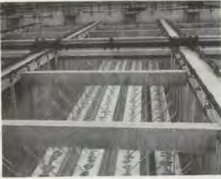
a. Inblåsning av finfördelad luft genom porösa plattor, fördelade över bassängens hela botten. Activated Sludge Co., Ltd., London.
