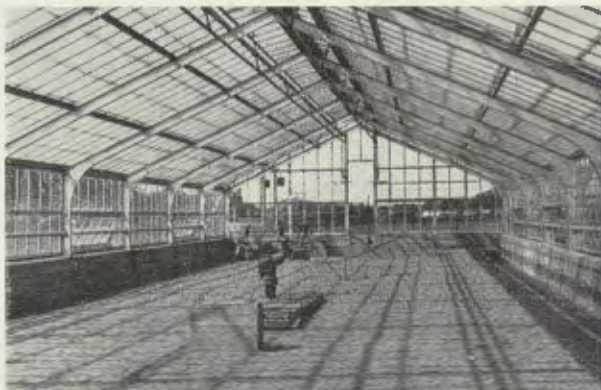
Fig. 73. Glastäckt slamtorkgård (under utförande). Mölndal.
