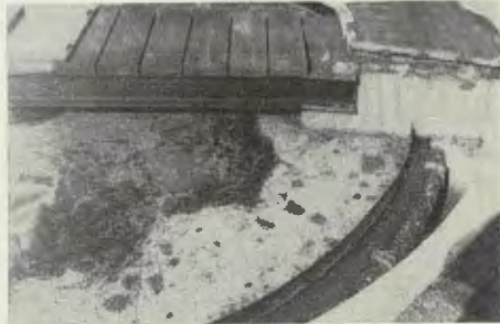
Fig. 75. Några dagar gammalt flytslamtäckte i emscherbrunn vid sjukhusanläggning.
