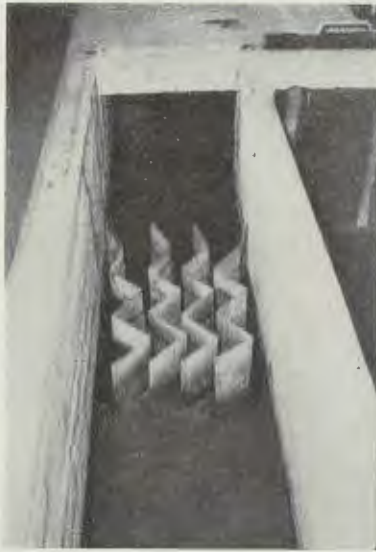
Fig. 33. Galler avsett att hindra långa föremål att passera.
