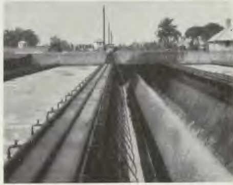
b. Samma system som enligt a, men tillämpat för luftning av återgångsslam. Observera den branta bottenlutningen.
