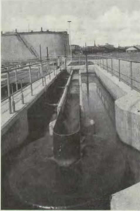
Fig. 36. Sandfångare enligt Vattenbyggnadsbyråns konstruktion. I förgr. sandfångarens inloppsända under pågående sanduppfördring och sandtvättning. Västerås.
