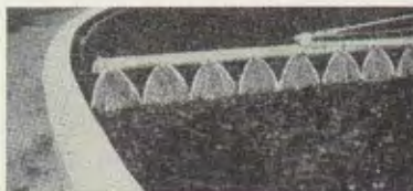
Fig. 50. Detalj av roterande spridare.
