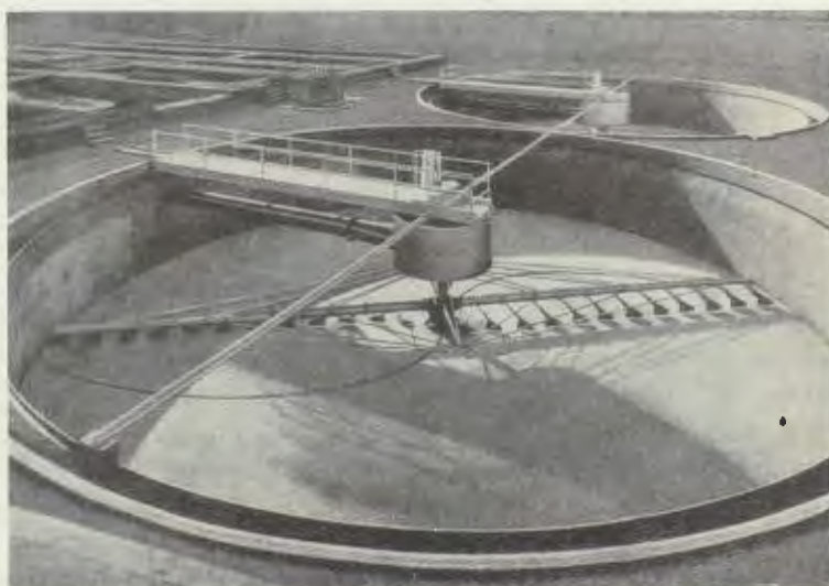
Fig. 45. Sedimenteringsbassänger med cirkulär planform och roterande slamsug. Topeka, Kansas, U. S. A.
