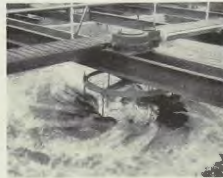
f. Luftning medelst roterande skovelhjul i vattenytan. Cirkulation åtvägbringas av skovelhjulet genom ett centralt vertikalt rör. System Simplex.
