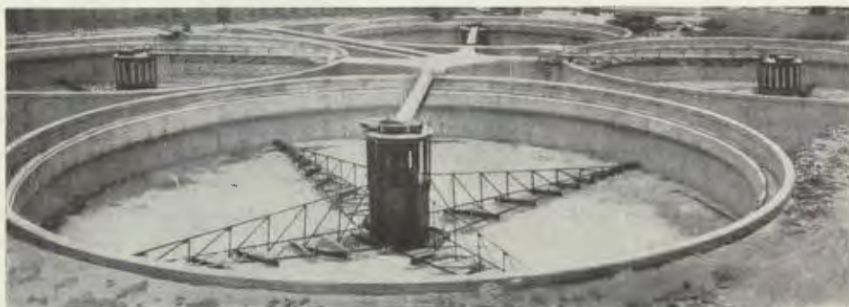
Fig. 44. Sedimenteringsbassänger med cirkulär planform och roterande slamskrapor av Dorr-typ. Cleveland, Ohio, U. S. A.
