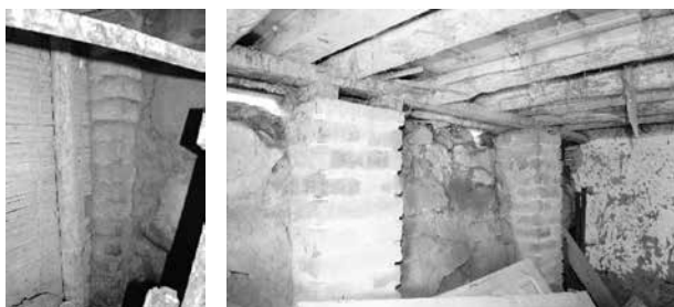
Columna de mampostería simple aisladas
