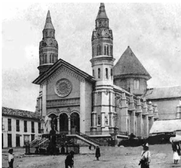
Figura 13. Aspecto de la primera catedral de Manizales, construida ‘en madera’ y forrada en láminas metálicas importadas. Estilo ecléctico que mezclaba el neo bizantino, el neo románico y el neo gótico. Obsérvense los contrafuertes y arbotantes laterales, propios de este último.
