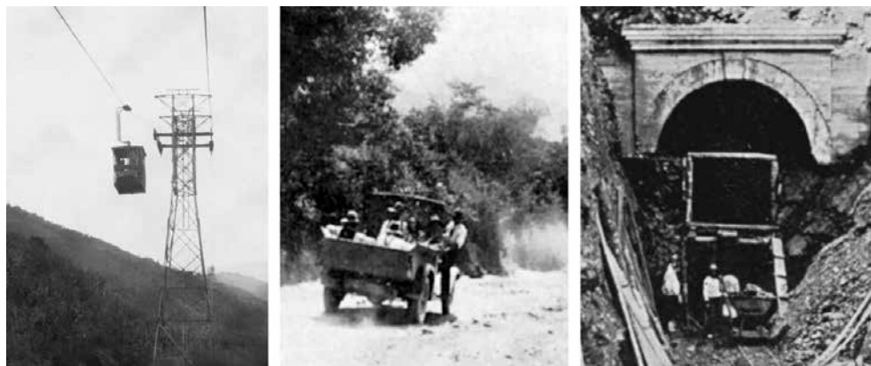
Figuras 32, 33 y 34. Estado de las vías modernas para conectar a Manizales: a la izquierda, el cable aéreo a Mariquita; al centro, estado de la carretera a San Francisco (Chinchiná); y a la derecha, construcción de uno de los túneles, cercanos a Manizales, del ferrocarril de Caldas, a principios de 1927.
