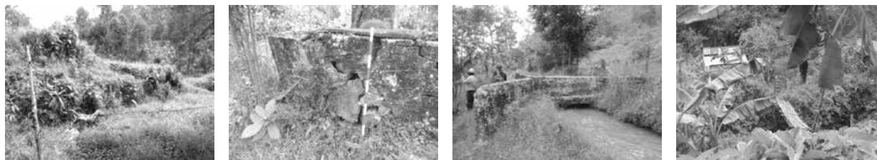
Muro de roca en la margen izquierda, muro en piedra cubierto con mortero pegado, puente sobre canal de CHEC y puente en guadua sobre el río Chinchiná.
