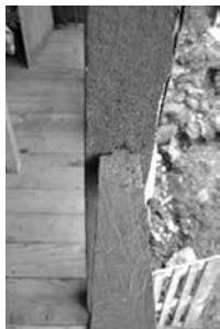
Detalle unión de las barandas.
