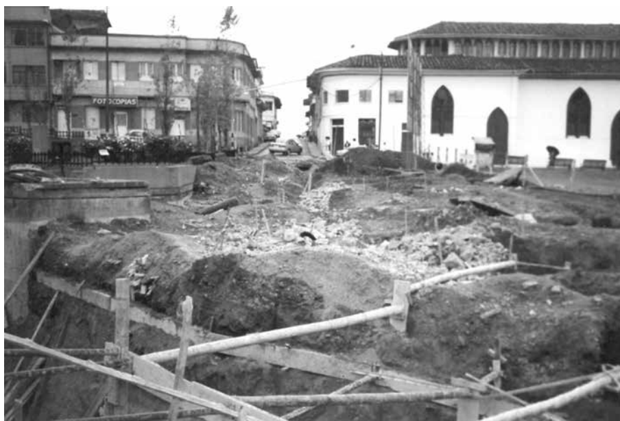
Obras de construcción de la avenida Fundadores. En la parte superior izquierda, el lugar aproximado donde quedaba la Funeraria La Equitativa. Fotografía / Cortesía.
