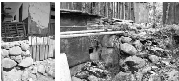
Muro de contención y cimentación en concreto ciclópeo
