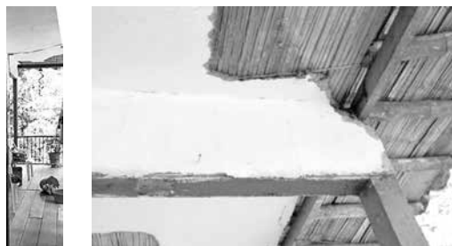
En la foto de la izquierda, el pórtico de remate del zaguán de acceso y en la foto de la derecha su unión con el cielorraso.
