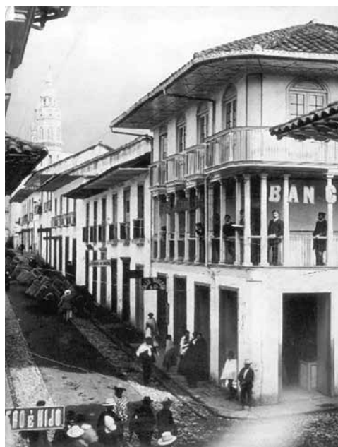
Figura 5. Ejemplo de ‘estilo temblorero’, hacia 1910, de una construcción de tres pisos. El Banco de los Andes, en Manizales, cuya primera planta era en tapia pisada o calicanto, y los dos superiores en bahareque. Obsérvese cómo los amplios aleros protegen de la humedad tanto los muros de tierra de las fachadas, como las maderas de los balcones y la galería.
