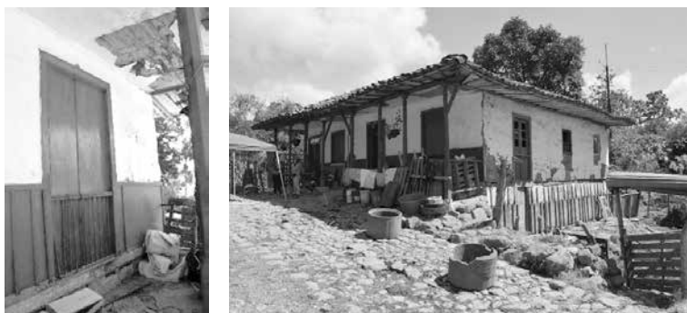
Puerta-ventana de las habitaciones con chambranas.
