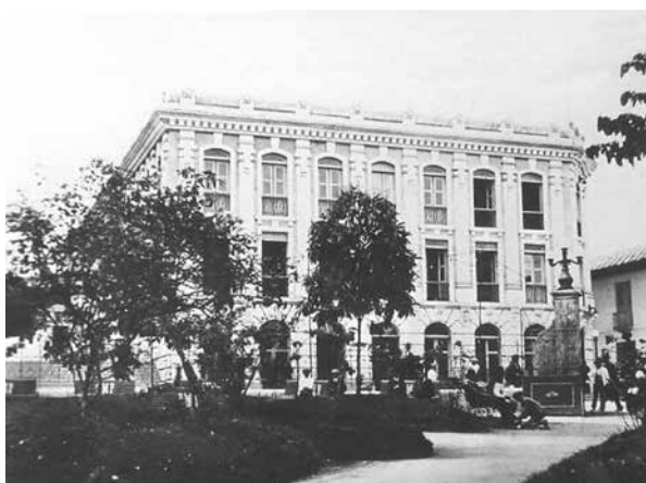
Figura 15. Edificio de estilo temblorero que compartía la manzana con la primera catedral: el Banco de Caldas, en los ‘bajos’ (en calicanto), y el Hotel Internacional en los superiores (en ‘bahareque encementado’). Posiblemente dinamitado, en 1925, para salvar a la catedral de la propagación de las llamas durante el incendio.
