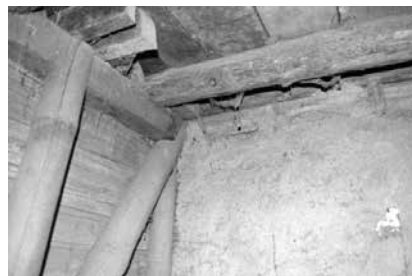
Se observa en fachada columna de ladrillos, Se observa madera procesada y rolliza.
