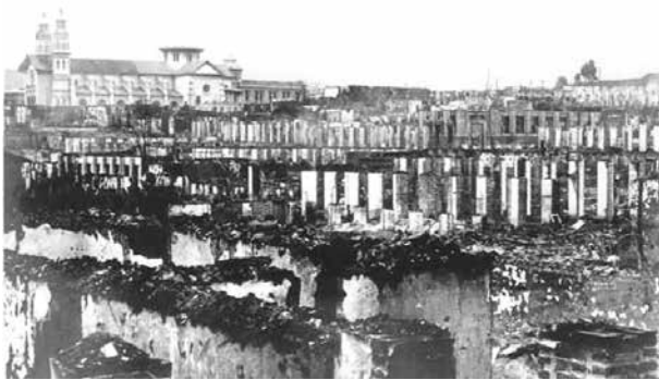
Figura 16. Aspecto de la destrucción causada por el incendio de julio de 1925. Se observan, en pie, los muros de tapia o de calicanto de los primeros pisos de la mayoría de las viviendas. El fondo, la antigua catedral, salvada 'milagrosamente'.
