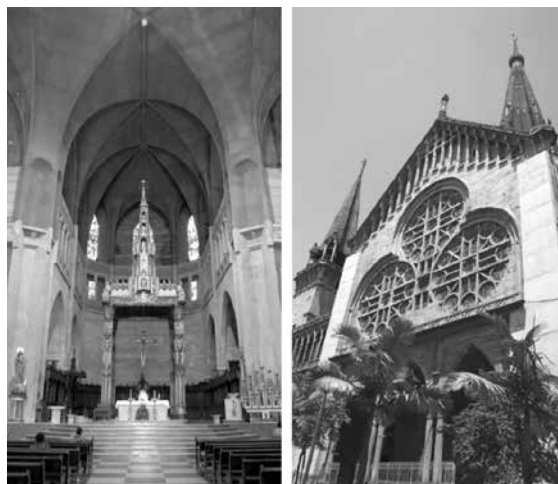
Figuras 38 y 39. Catedral de Manizales. A la izquierda, aspecto del espacio interior abovedado, sostenido en macizos pilares de hormigón armado; a la derecha, costado exterior, en el que no aparecen los característicos contrafuertes y arbotantes del estilo gótico. Fotografías originales en color: Germán Augusto Valencia Mesa.
