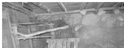
Solera de madera, entrepiso en madera y guadua, acabado en tabla.
