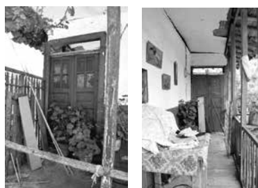
Antigua puerta de ingreso desde la fachada y desde el corredor interno.
