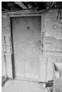
Se observa puerta de la primera vivienda, con el color que recubría la vivienda inicialmente.
