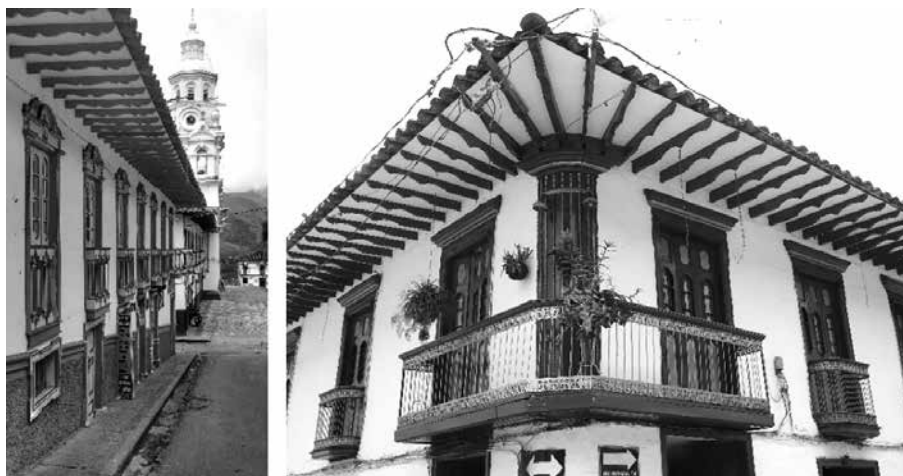
Figuras 6 y 7. Arquitectura republicana con alero en Salamina, Caldas. A la izquierda, conjunto urbano declarado Bien de Interés Cultural Nacional; a la derecha, balcón esquinero, uno de los primeros trabajos del tallador Eliseo Tangarife, en los inicios del siglo XX. Todos los motivos estilísticos están plasmados en las maderas. Fotografías: Arquitecto Jorge Enrique Esguerra.
