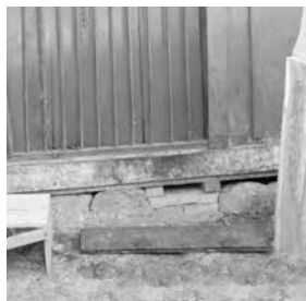
Se observa en fachada columna de ladrillos, entrepiso en madera y acabado de tablas.
