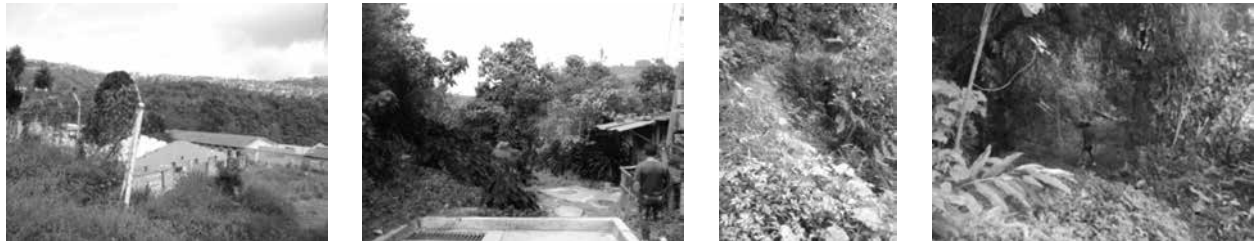
Recorrido oriente-occidente: Infraestructura de las Granjas de Villamaría desmanteladas y al fondo Manizales, calle cerrada ingreso a lo que era el camino, derrumbe y detalle de lo que queda del camino (año 2018)
