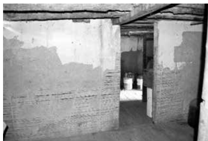
Acabado del piso y de los muros del nivel inferior.
