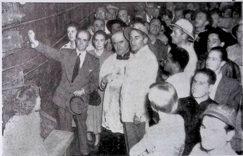
Su Excelencia Reverendísima Monseñor Álvarez Restrepo, Obispo Auxiliar de la Diócesis de Manizales, y el doctor Fernando Londoño Londoño, Alcalde Mayor de la ciudad, en el momento de hacer la conexión eléctrica para volar los dos metros terminales de roca en la perforación del TUNEL DE CURAZAO.
