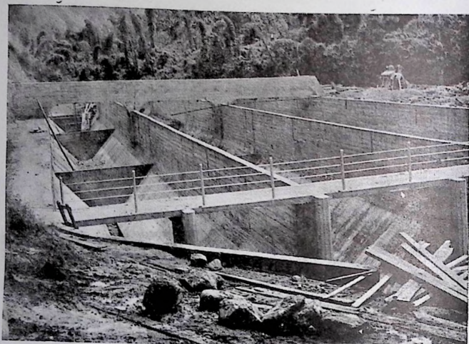
Desarenador cerca a la Boca-toma de la CENTRAL HIDROELECTRICA DE CALDAS.
