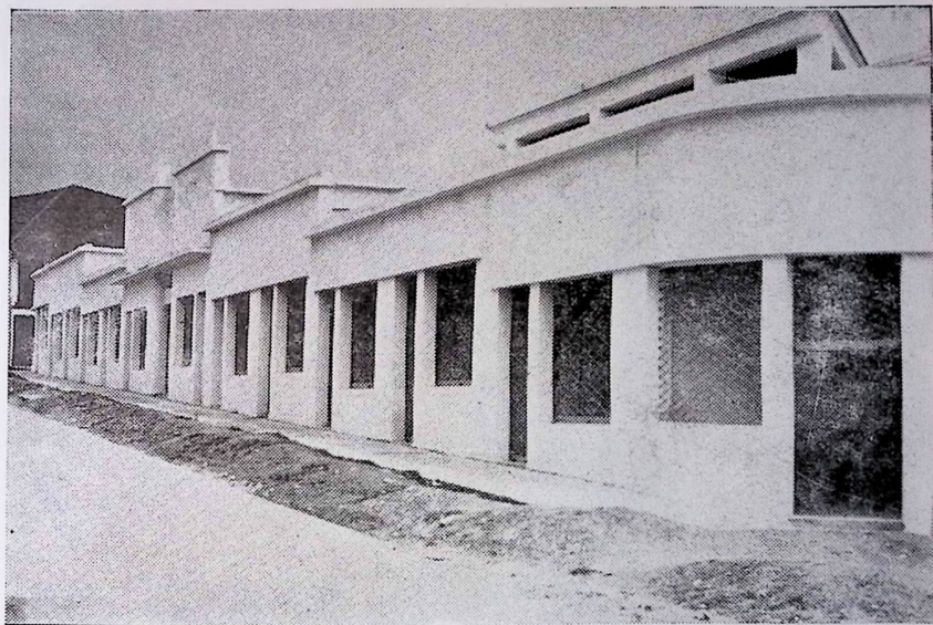
Aspecto de uno de los pabellones de las Galerías Modernas, en construcción. Manizales
