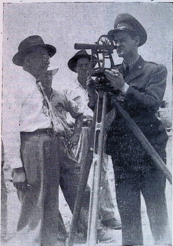
Aparece en esta vista el Capitán Figueroa, de la Comisión de Aero-náutica Civil, verificando los chequeos de la nivelación del Campo de Aterrizaje de Santa Agueda al momento de entregar la Compañía Panamericana de Construcciones el primer sector de la pista.
