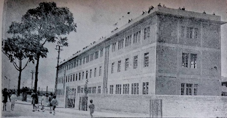
Aspecto exterior del Seminario Conciliar, gran edificio levantado en la Avenida Santander e inaugurado recientemente. :: : :: ::
