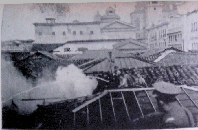
Un aspecto del incendio ocurrido el 28 de febrero en el edificio de Hijos de Juan de J. Calle. :: ::
