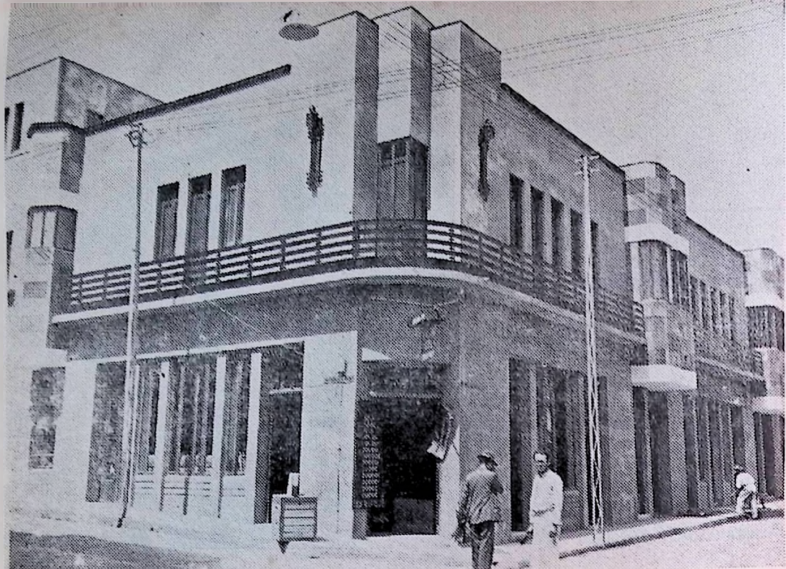
Manizales moderno. - Edificio del doctor José Restrepo Restrepo, en la carrera 11.
