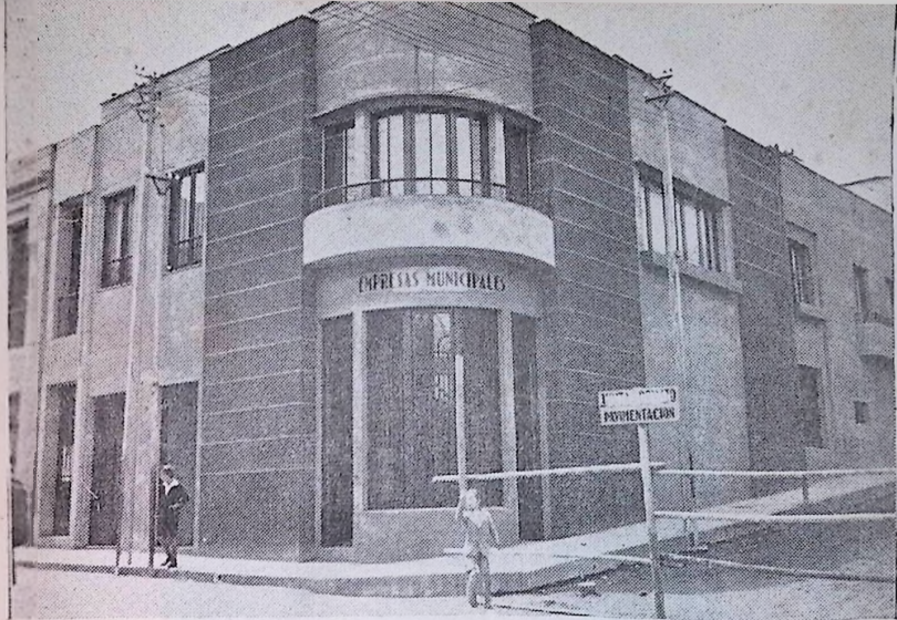
Manizales Moderno. - Suntuoso edificio de propiedad de don Luis Horacio Gómez. - Carrera 13.
