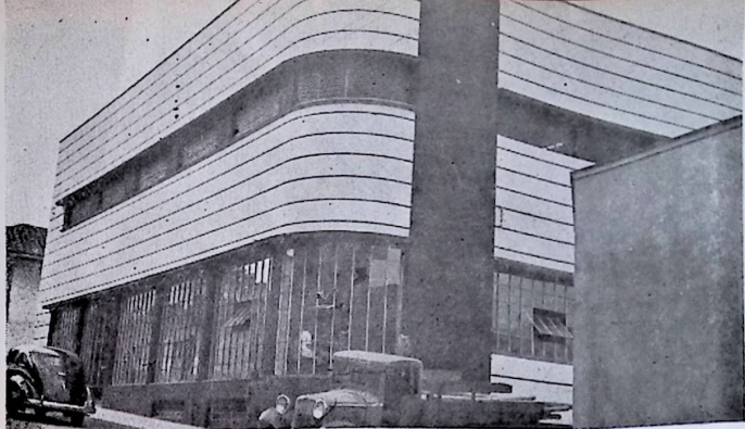
Otro aspecto del lujoso edificio del Comité de Cafeteros.—Carrera 22, calle 18. :: :: ::
