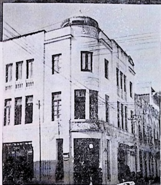
Manizales. - Nevados del Ruiz. - Edificio de don Francisco Jaramillo Ochoa, en la carrera 22. ::
