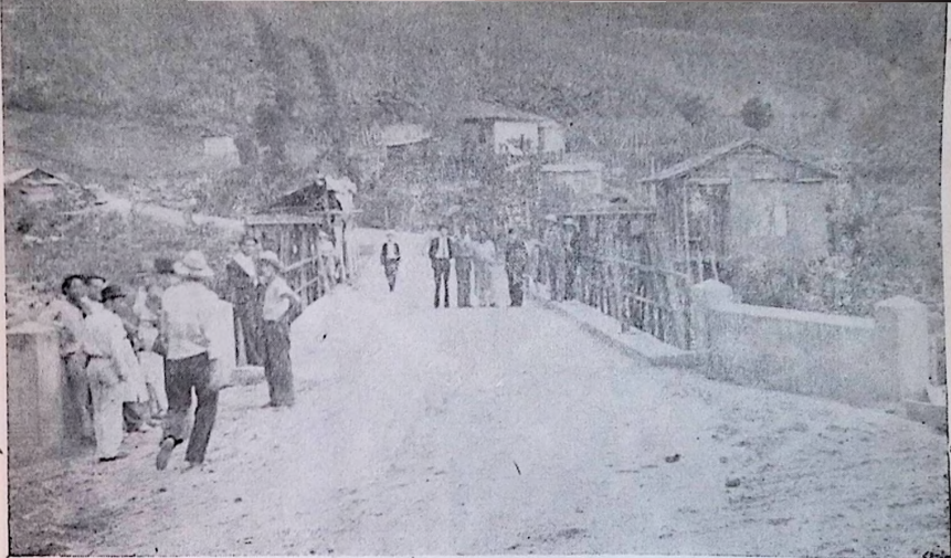
Puente de "Tareas", en el sector Neira-Aranzazu, magnífica obra construida mediante contrato con don Francisco Jaramillo Ochoa. :: :: :: ::
