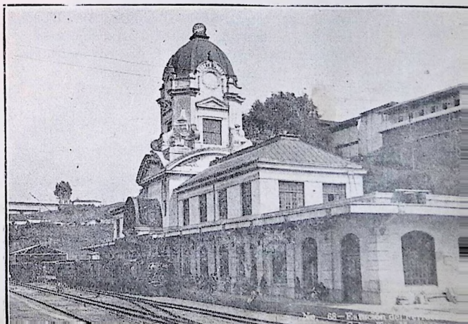
Estación del Ferrocarril en Manizales.
