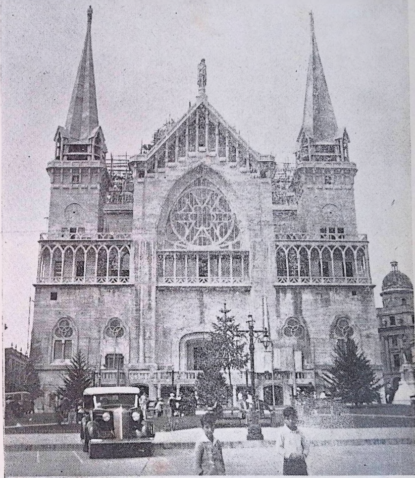
El frontis de la nueva Catedral, en su estado actual de construcción.
