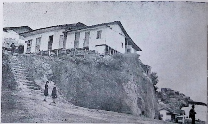
Aspecto de la Plaza de Occidente en construcción, obra que se adelanta, mediante los esfuerzos de la Sociedad de Mejoras Públicas.
