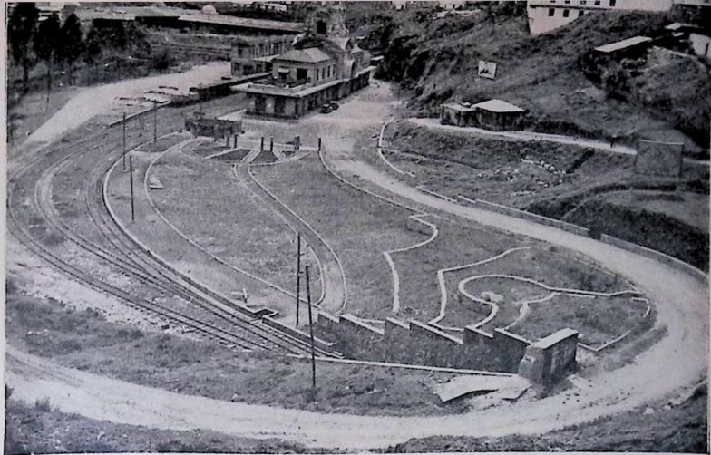
Vista panorámica de la Estación del Ferrocarril. Manizales.
