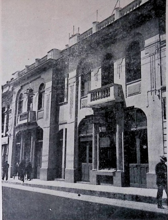
Manizales Moderno. - Edificios de los señores Alfonso Jaramillo R. y doctor José Restrepo Restrepo, situados en la carrera 13 entre calles 13 y 14.
