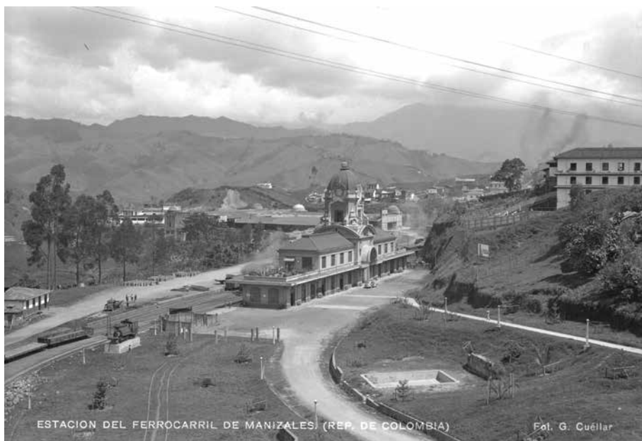
Estación del ferrocarril de Manizales | Cuéllar Jiménez, Gumersindo, 1891-1958
