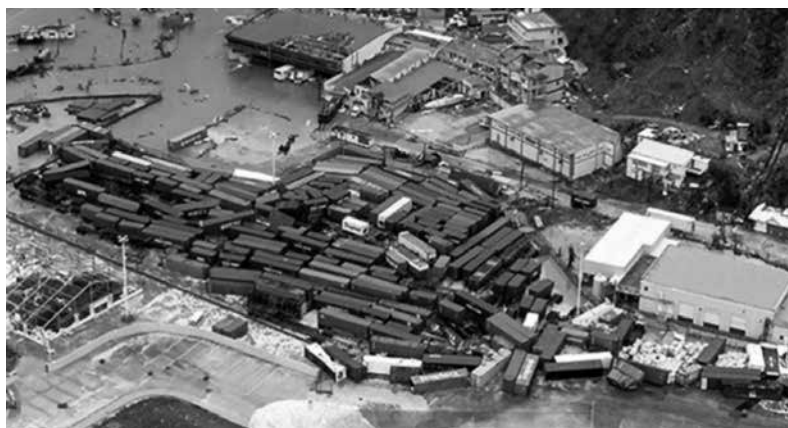
Imagen. Puerto con contenedores en Philipsburg, arruinado por el Huracán Irma en 2017.
