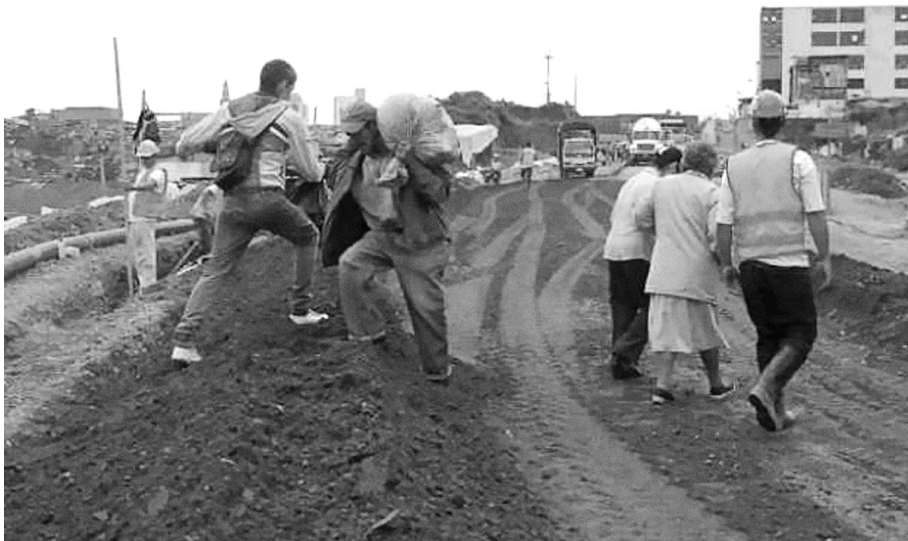
Obras en el Macro proyecto San José. Foto | Darío Augusto Cardona | LA PATRIA
