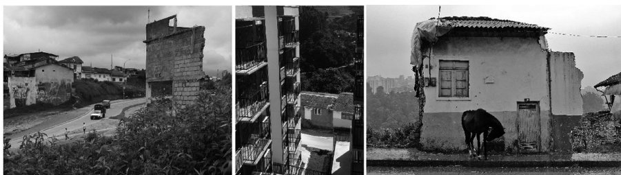
Imágenes de áreas intervenidas de la comuna San José. Fuente propia.
