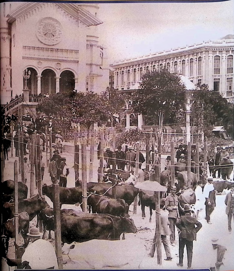
Antigua Catedral, destruida en el incendio de 1926. Exposición pecuaria de Manizales - 1923
