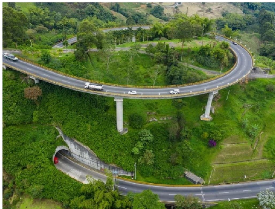
Viaductos en Dosquebradas, de Autopistas del Café. El Tiempo
