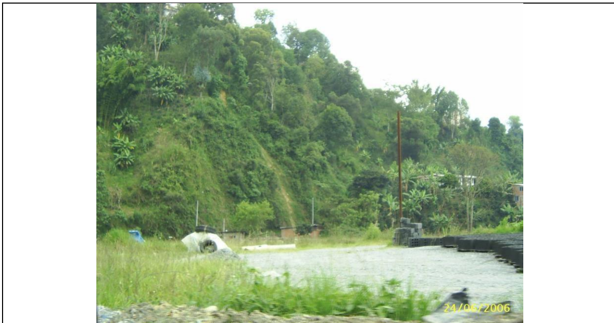
Figura 2 f. Túnel Manizales- Portal Sur: Opción Panamericana. El macizo rocoso presenta mejores condiciones para la salida del túnel hacia el costado occidental, por el tercio izquierdo de la foto. Esto supone que el túnel debe quebrar su alineamiento recto, una centena de metros o más, antes de salir.
