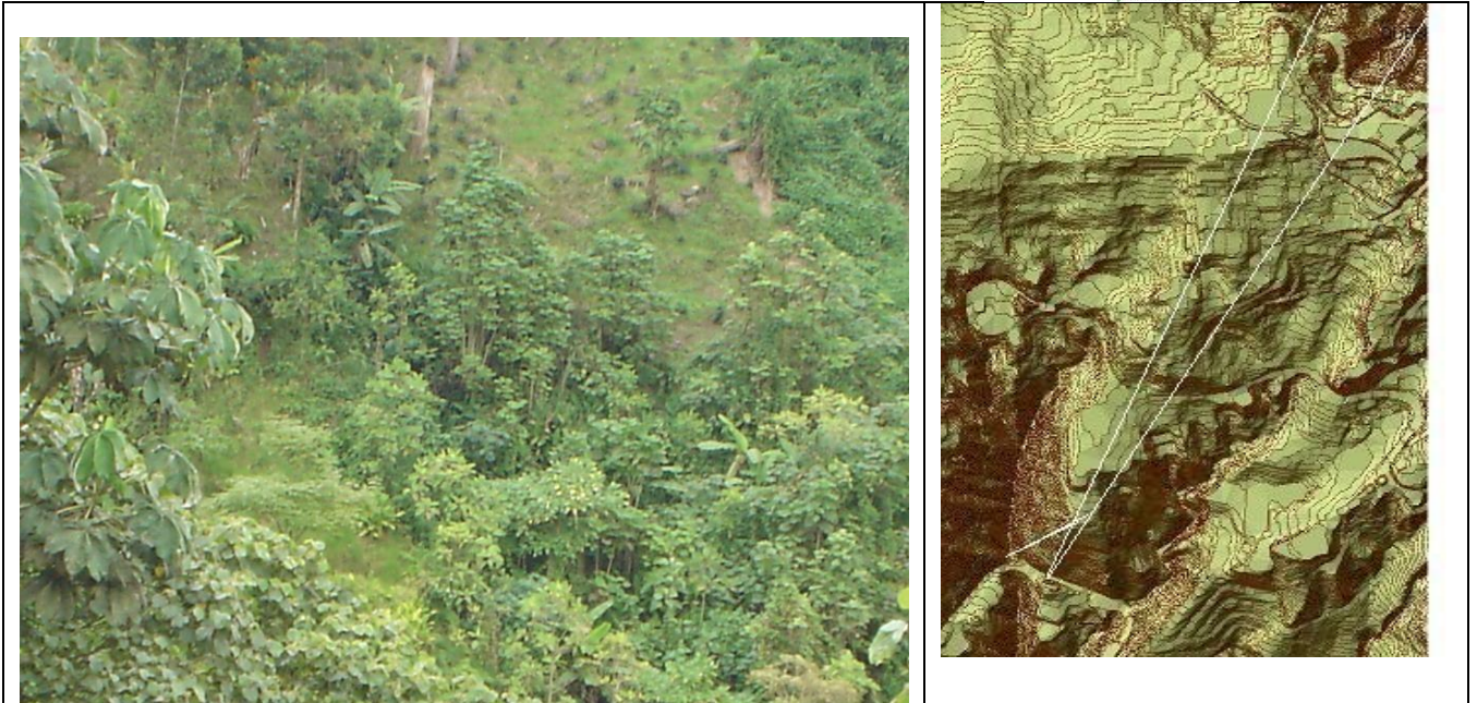
Figura 2 c. Túnel Manizales: Opción Estrada para el portal del norte (Izq). Y vista de las dos alternativas del túnel en imagen digital, en línea blanca. Obsérvese el relieve en la parte superior, vecina a Fundadores.
