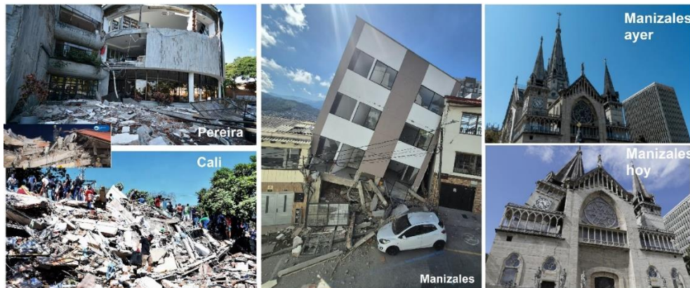
Imagen: Colombia- daños estructurales y colapso de edificios por Sismo del 10-08-2026. Fuentes varias.
