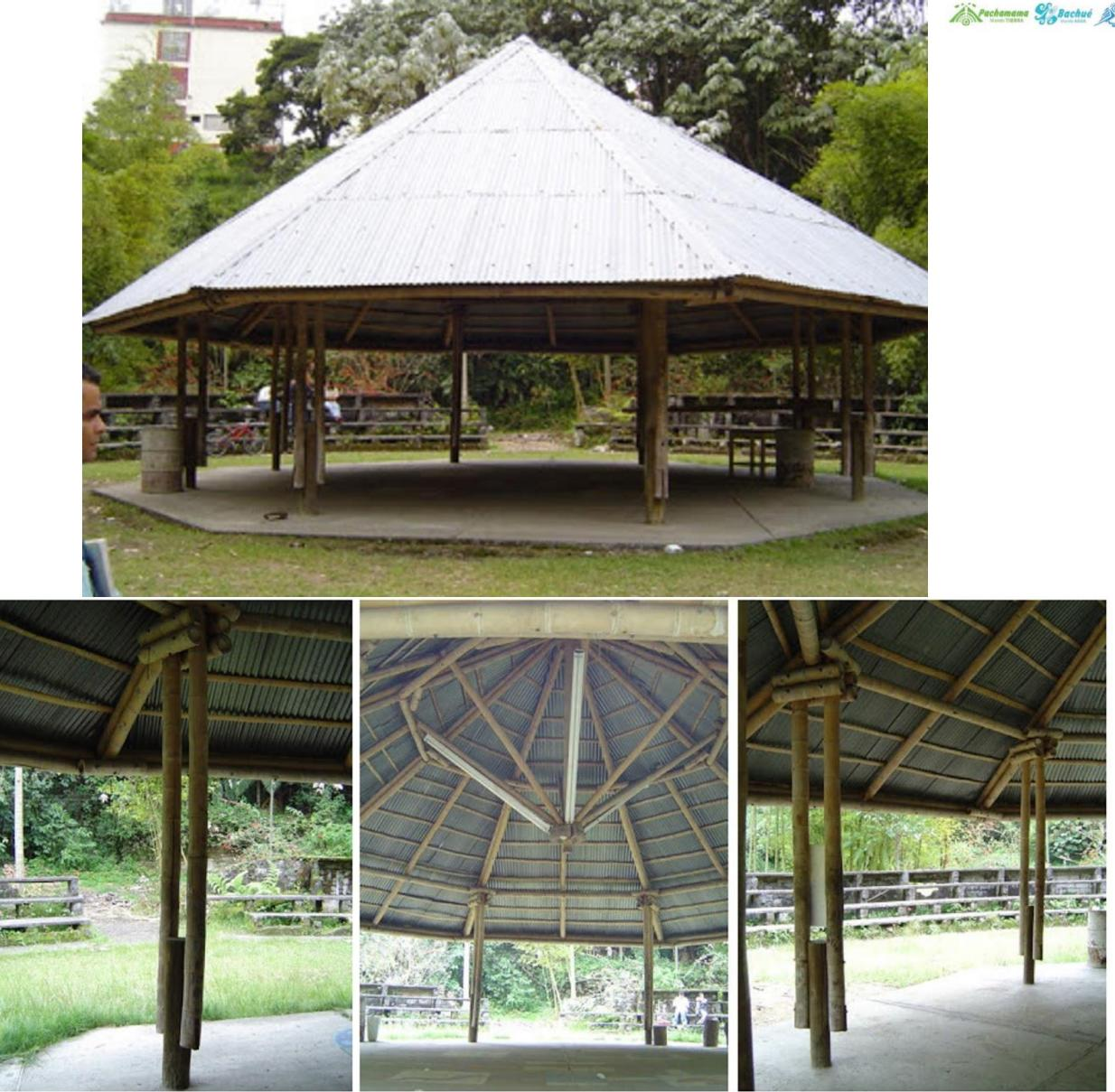
En esta construcción de bahareque con estructura de bambú, diseño sismo-resistente y amigable con el medio ambiente, las columnas se inician en vástagos empotrados 1 m en el suelo, razón por la cual el mangle debió ser tratado para soportar la humedad. En su defecto, pueden utilizarse postes de concreto.
