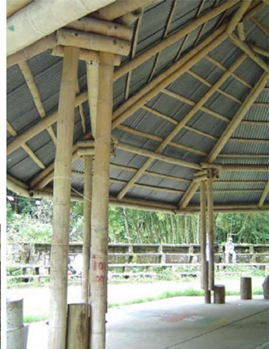
El kiosco o quiosco diseñado por Gonzalo Duque-Escobar y que se construyó en la década de 1990 con guadua de la Hda. Java -localizada en la vereda Java vecina al Bajo Tablazo en Manizales-, posteriormente se trasladó al Jardín Botánico de la Universidad de Caldas, donde el techo de palma de iraca se cambió por láminas metálicas de Zink .
