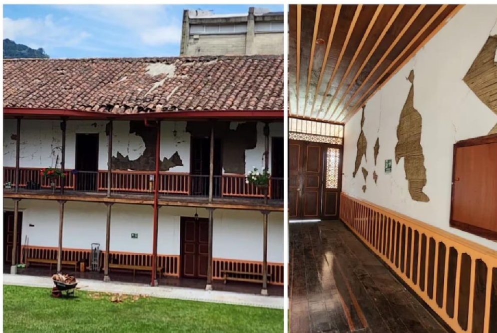
Imagen 06- Reconstrucción y arquitectura del PCC. Escuela Apostólica en Santa Rosa-Risaralda. Mincultura en Infobae.com
