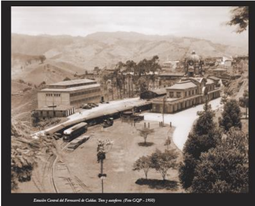
Estación Manizales - Centro de Historia de Manizales
