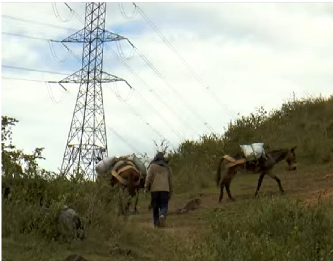
Imagen: Transmisión de energía eléctrica Grupoenergiabogota.com
