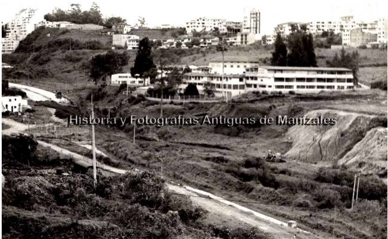
Imagen: Construcción Avenida Kevin Ángel, sector San Rafael en 1992.
