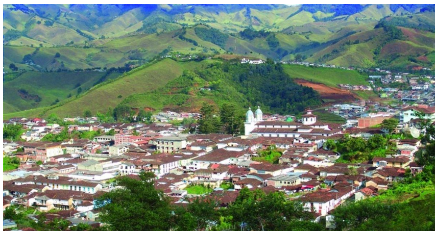
Imagen 6: Aguadas y su patrimonio arquitectónico del PCC. Alcaldía Municipal.
