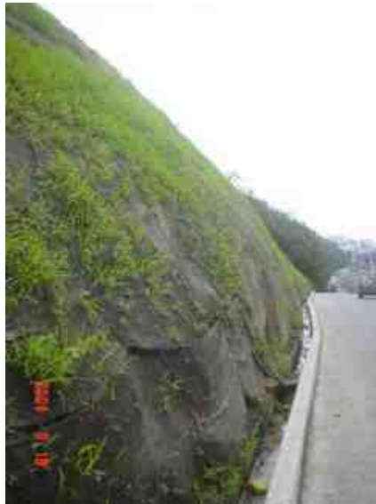
Fotografía 8.2. Talud escarpado conformado por un macizo rocoso vegetalizado con la incorporación de materia orgánica, semillas, estolones, protegidos con una tela de fique. (Carlos E. Escobar P.)
