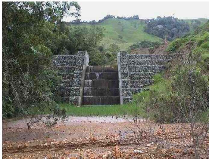
Figura 8.1 La Corrección de la quebrada El Silencio incluyó la instalación de diques de consolidación en gaviones y la regeneración natural con especies endémicas de la región. (Carlos E. Escobar P.)
