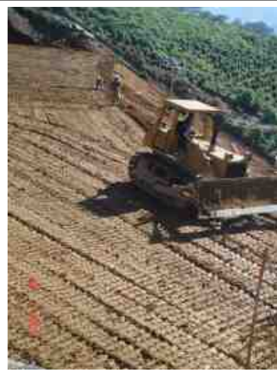
Figura 1.3 La construcción de estructuras en tierra incluye la disposición y compactación del suelo, el control de la humedad, el drenaje del suelo y la conformación del talud estable. (Carlos E
