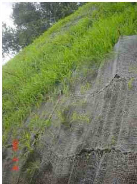
Figura 8.3. El tratamiento con suelo orgánico, gallinaza, semillas y tela de fique son estrategias para establecer vegetación en taludes pendientes de roca. (Carlos E. Escobar P.)
