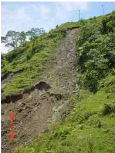
Figura 6.8. Deslizamientos con planos de falla superficiales. Estos movimientos en masa fueron activados por una lluvia torrencial de 140 mm en 4 horas. (Carlos E. Escobar P.)
