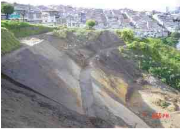
Figura 1.4 Talud conformado por suelo natural relleno. Los colores que exhiben los suelos reflejan su origen: unos son el resultado de la descomposición de la roca, otros son
