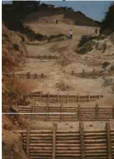
Figura 8.11 Trinchos en guadua para confinar un antiguo cauce y apoyar labores de establecimiento de vegetación. (Carlos E. Escobar P.)
