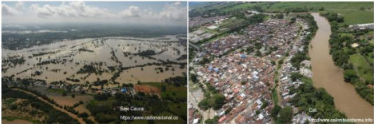
Imagen 4.107: Nechí en el Bajo Cauca y Jarillón del Río Cauca – Oriente de Cali. Fuente: Radio Nacional y Colombia Informa.
