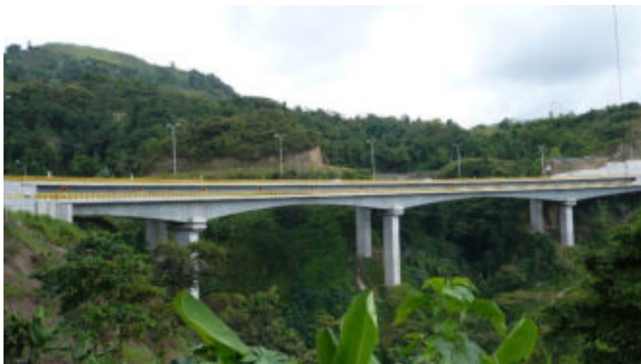
Imagen 2.68. Viaducto de La Estampilla. En Wikipedia.org.
