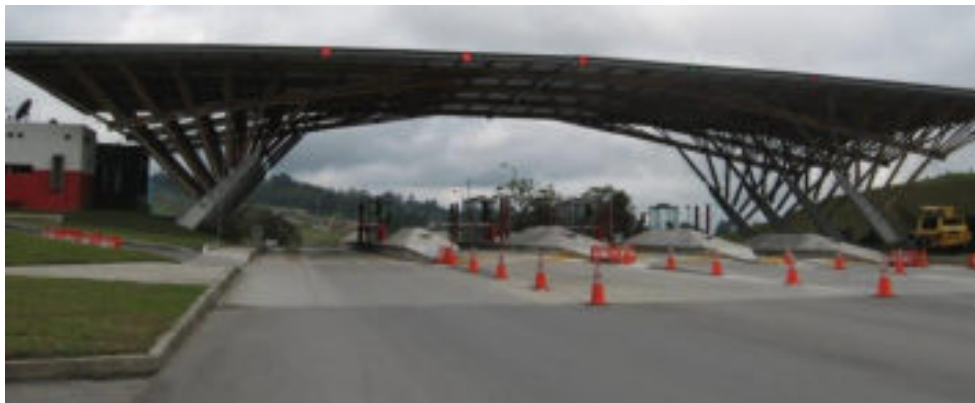
Imagen 4.64: Estructura en bambú para las casetas de peaje de Autopistas del Café en Quindío.
