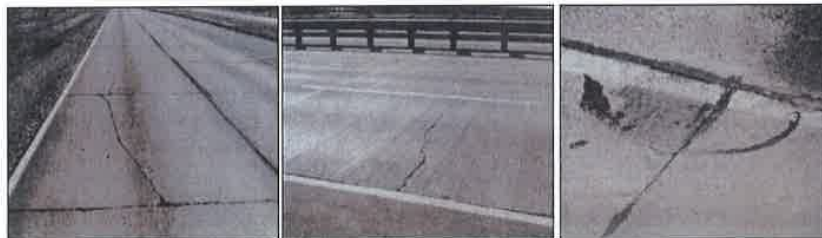
LONGITUDINAL CRACKING
