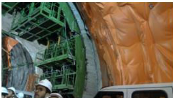
Figura 4: impermeabilizzazione a doppia saldatura termica.
