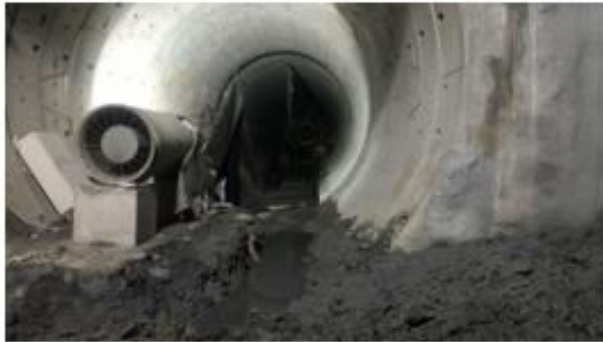
Figura 1: Testa della TBM murata all'interno del tunnel dopo alcuni ragionamenti dal punto di vista economico.
