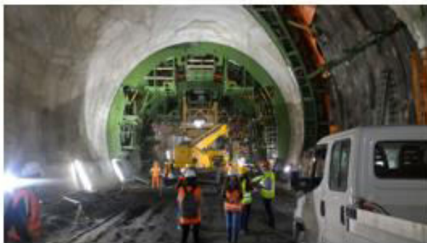
Figura 2: cassaforma mobile utilizzata per il final lining
