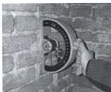
PROVA SCLEROMETRICA SU BLOCCHI (A) E SU MALTE (B)
