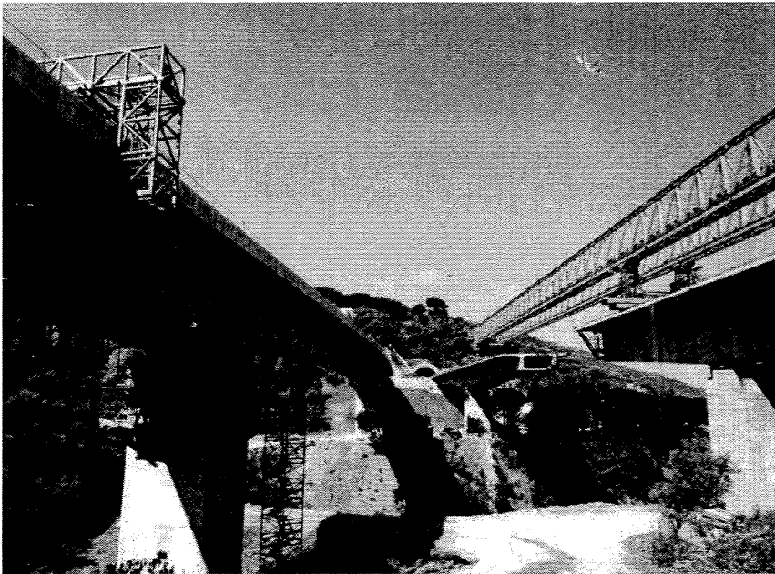
Vallone Marzo Viaduct: Launching girder
