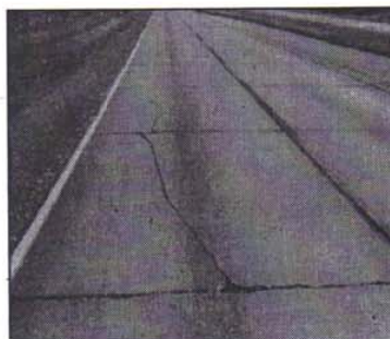
FESSURAZIONE LONGITUDINALE
