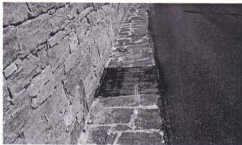
CUNETTA RIVESTITA IN PIETRA
