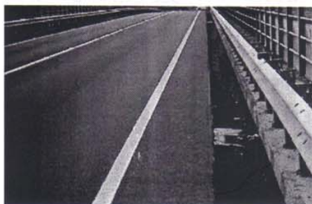
CUNETTA RIVESTITA IN CLB CONGLOMERATO BITUMINOSO
