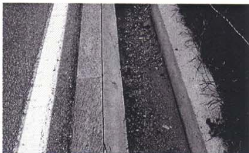
CUNETTA RETTANGOLARE IN ELEMENTI PREFABBRICATI IN CLS
