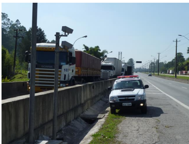
FIGURA 49 – Câmeras para Detecção de Fugas pelo By-pass
