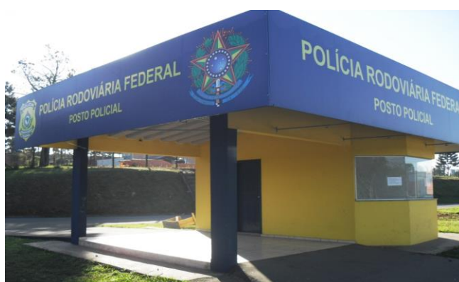
FIGURA 60 – Posto de Interceptação de Fugas
