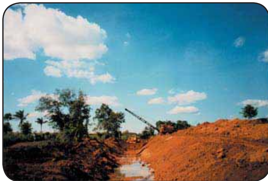
Foto 31 — Dragagem com drag-line
