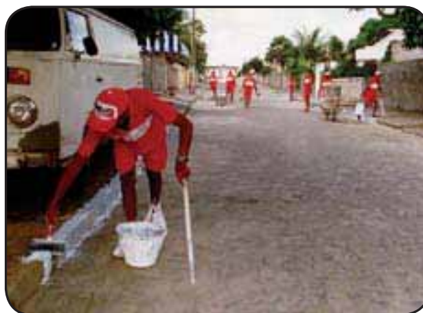
Foto 18 — Pintura de meio-fio
