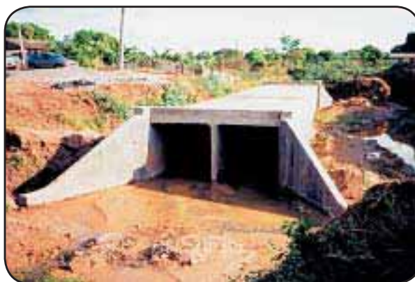
Foto 30 — Galeria de Concreto Armado
