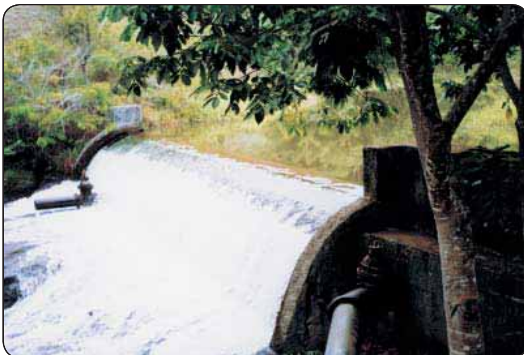
Foto 1 - Tomada direta com barragem de nível
