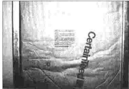
Foto 17. Isolamento por Mantas de fibras entre os montantes de Aço.
