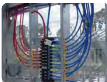
Sistema Hidráulico tipo PEX
