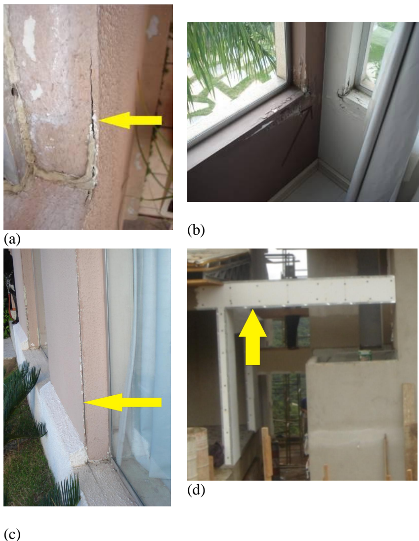
Figura 13 – (a, b, c) Trincas e infiltrações na interface das esquadrias/ (d) Cantoneira metálica nas quinas (Fig. 13 d- Fonte: Santiago, 2010)
