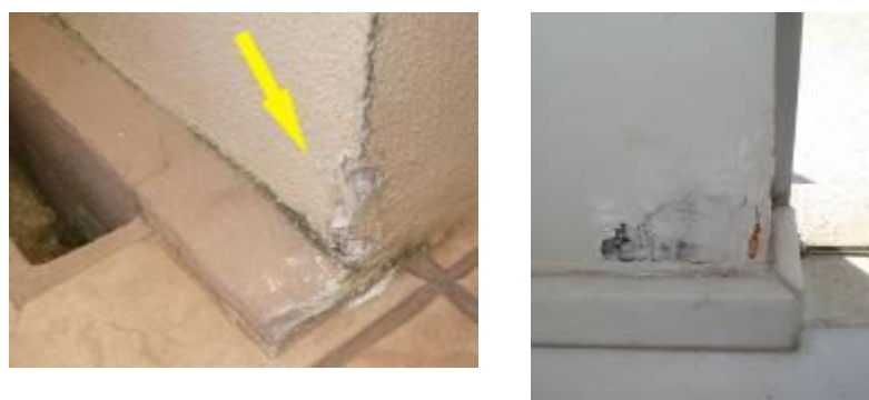
Figura 10 – (a) Rodapé sem proteção/ (b) Rodapé de pequena altura
